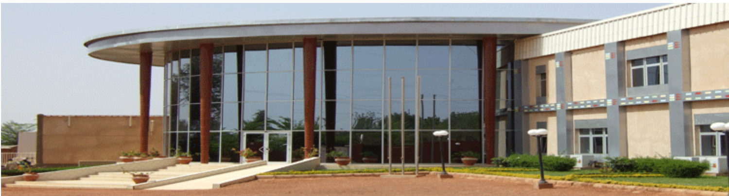
Usine de transformation des produits laitiers
